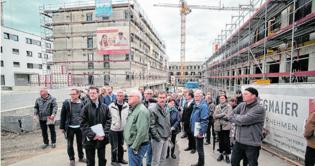
Interessierte Bürger beim „Tag der Städtebauförderung“ auf dem Aalener Stadtoval. Zwischen den künftigen Wohnhäusern erkennt man hinter dem Kran einen Querbau, den künftigen Kulturbahnhof. Foto: Oliver Giers
